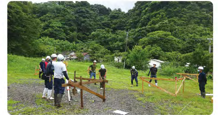
【応急仮設住宅の建設着手（7月11日）】
