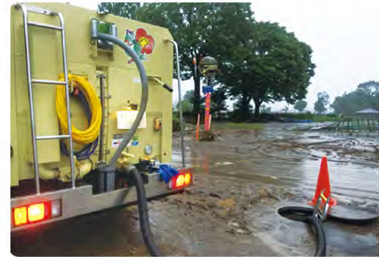
【災害協定に基づく汚水運搬作業】
