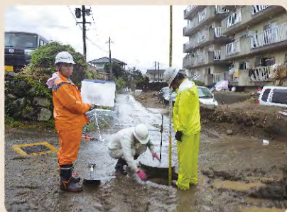
熊本市上下水道局による現地調査
