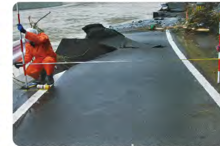
【災害協定に基づく被害状況調査】 提供：熊本県測量設計コンサルタンツ協会
