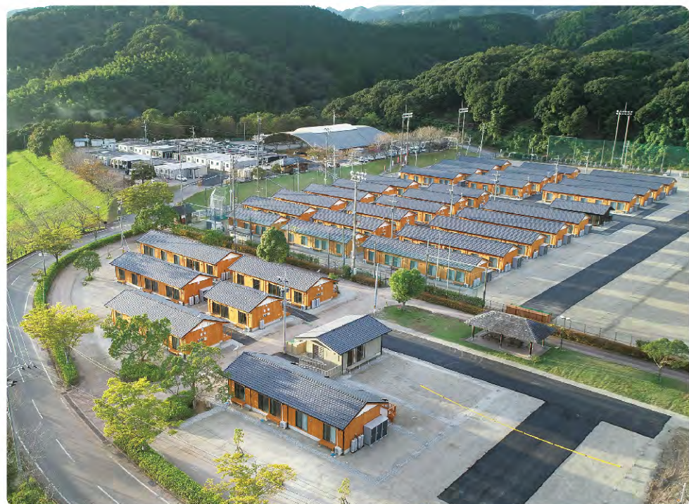
球磨村の木造仮設住宅団地
