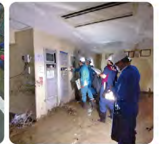
【災害協定に基づく被害状況調査】
