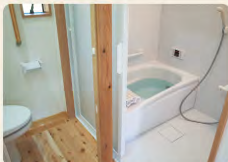
使い勝手が向上したトイレ・浴室まわり
