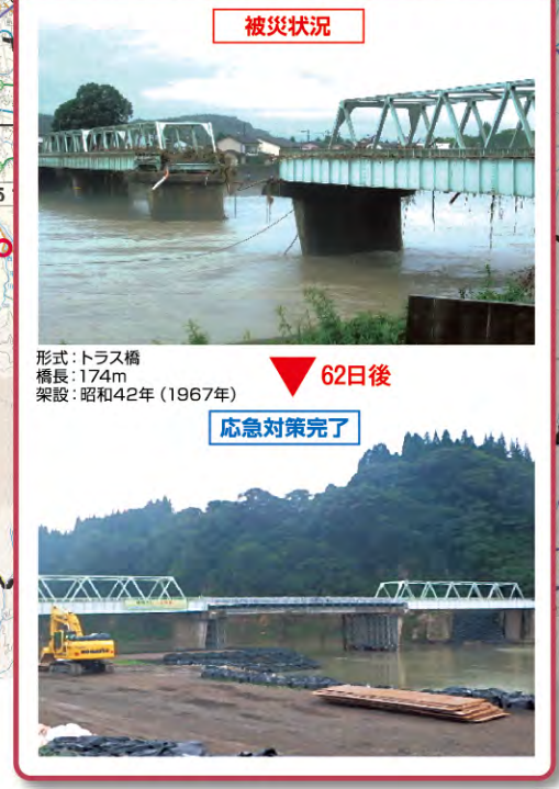
人吉水俣線(人吉市相良町)西瀬橋
