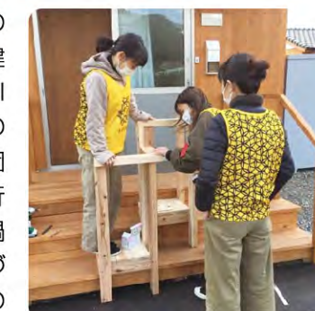
仮設住宅への段差歩行支援器具の設置
