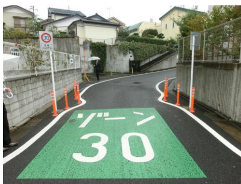
図表 43 ゾーン30の設置事例
