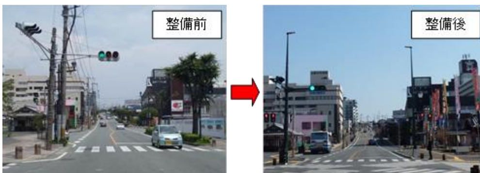
図表 42 熊本県山鹿市（歴史まちづくり法に基づく重点区域）における無電柱化の取組み
