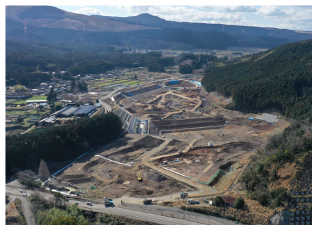
大切畑ダムの復旧状況（R5.2月）
