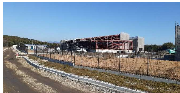
建設中の新工場（R4.12月時点）
