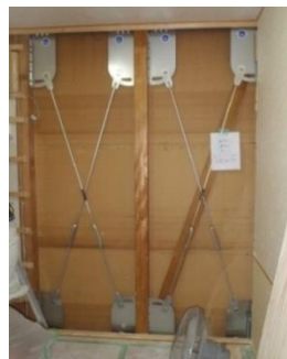
耐震改修工事例
