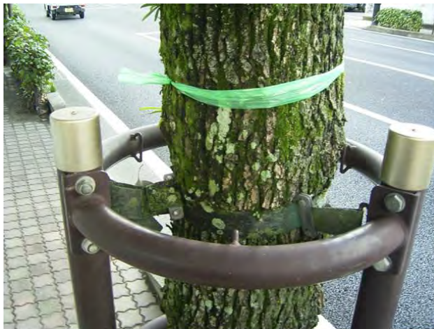
幹に食い込んだ支柱固定バンドの例
