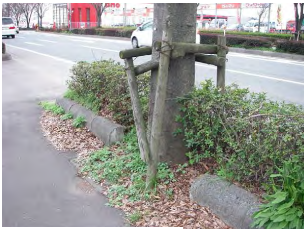
破損した支柱の放置例
