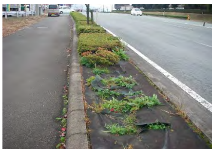
防草シートの敷込例
