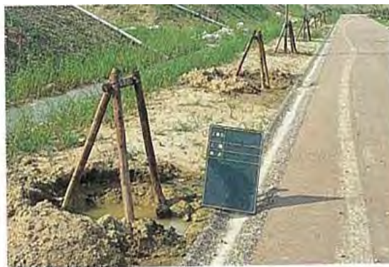
植栽基盤の水はけが悪化し枯損した事例
