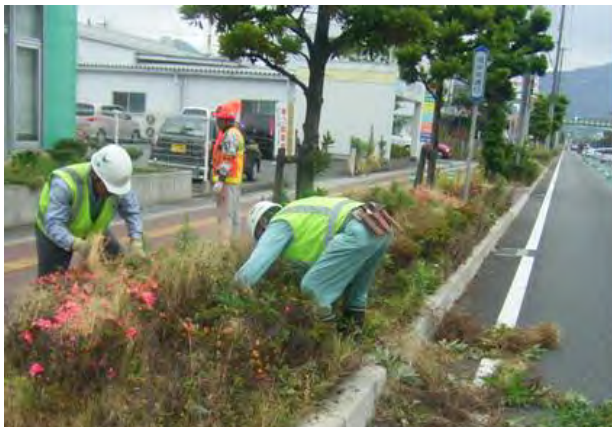
低木内の除草(手取り)作業状況
