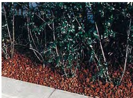
石材系骨材の敷込例
