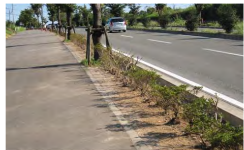
透水性ソイルコンクリートの舗装例 (植樹帯)
