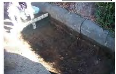
③-2表土掘削(路床面・基盤土まで)
