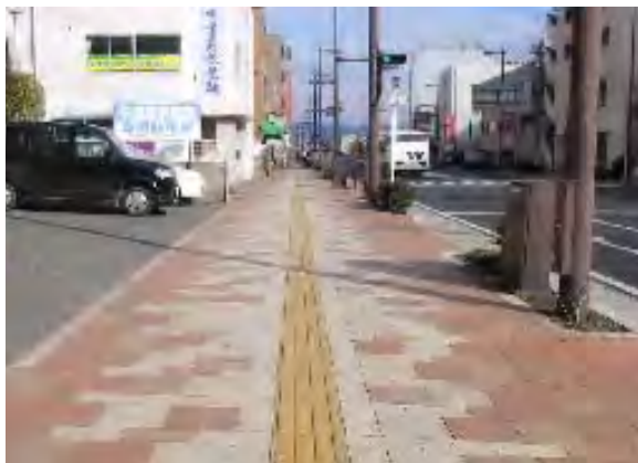
電線の地中化による街路樹のない都市空間の例
