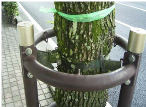
支柱材の幹食込み部は強風による幹折れの原因ともなる
