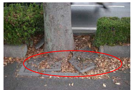
肥大化によるサークルの浮の事例
