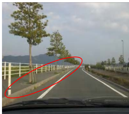
低木の撤去により鬱陶しさも無くなり歩道も広くなる（事例イメージ）
