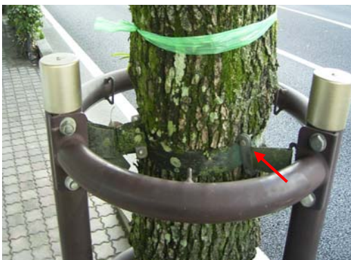
支柱材の幹食込み部は強風による幹折れの原因となる
