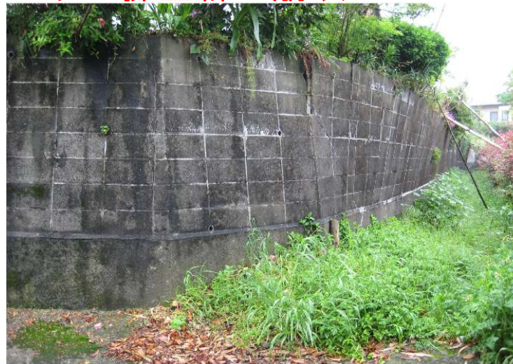
(a) 積みブロック擁壁群の崩壊
