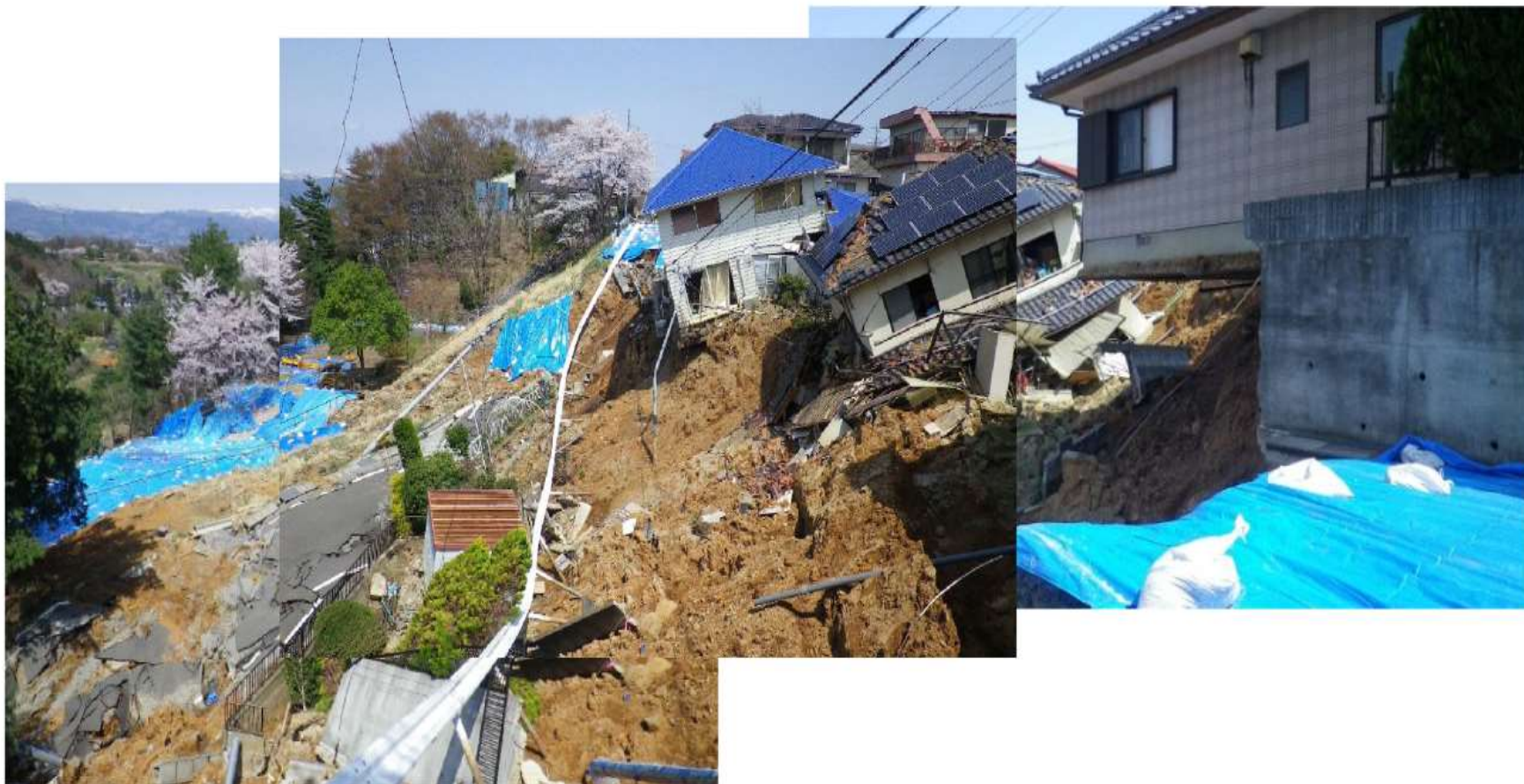
写3-11 のり面の崩壊の例
