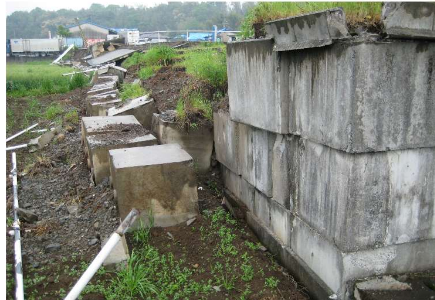
(a) 積みブロック擁壁群の崩壊
