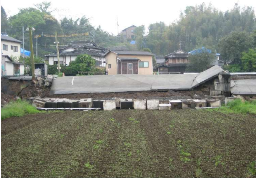
(a) 積みブロック擁壁群の崩壊
