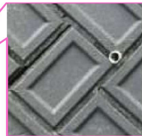
(b) 水抜穴が 20 mm と小さい事例
