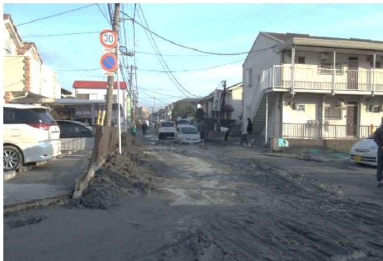
(a) 液状化の被害
