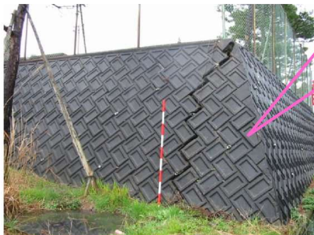
(b) 水抜穴が 20 mm と小さい事例
