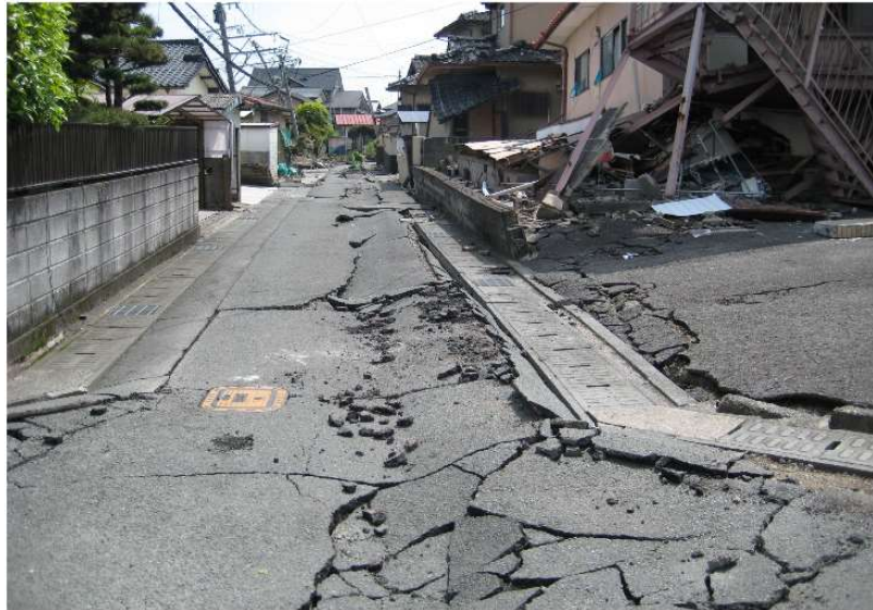
(a)道路の段差・隆起
