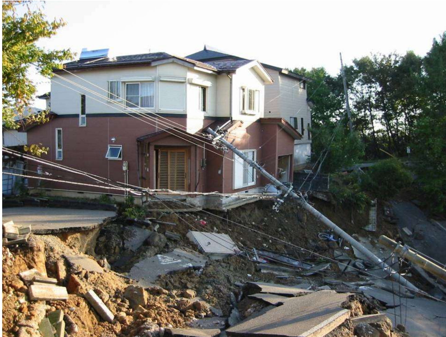
H16新潟県中越地震の被害
