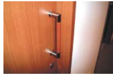
●通路面に出ない把手の収まりの例
