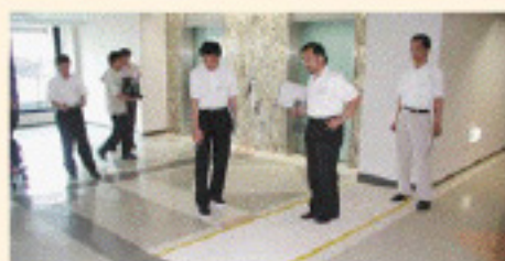
最適な勾配とするために現地に設けた仮の スロープで移動しやすさを確認している状況。 ※写真はすべて、県庁舎本館改修工事での取り組み状況。
