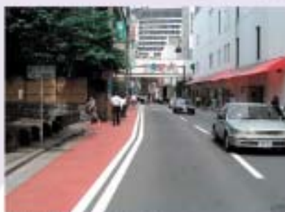
■路肩のカラー舗装化
