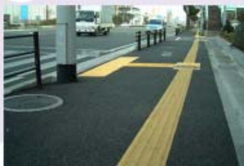
■歩道の透水性舗装
