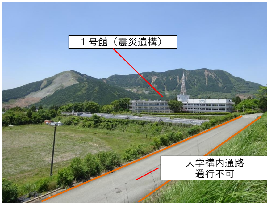
現況写真①
