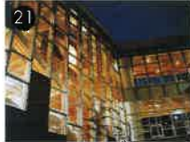
■ 水俣市保健センター・ 水俣市総合もやい直しセンター [水俣市]
