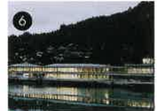
■ 荒瀬ダムボートハウス [八代郡坂本村]
