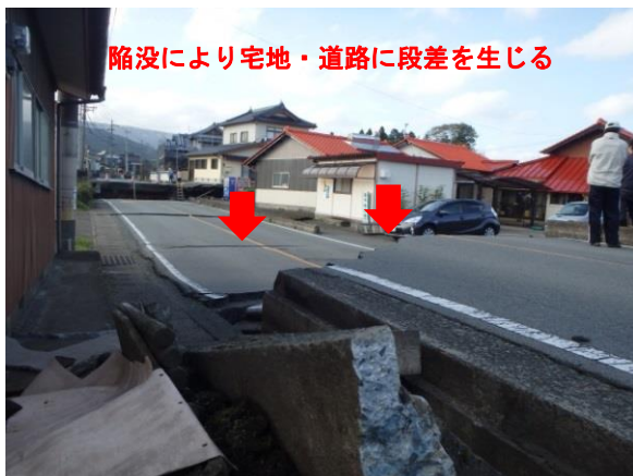
陥没に伴い段差が発生した宅地と道路
