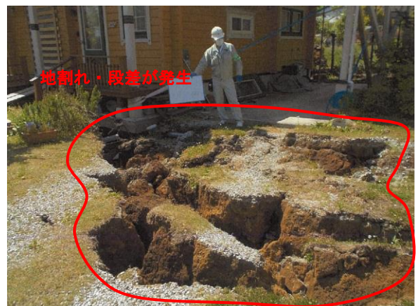
大きな地割れ・段差が発生した宅地
