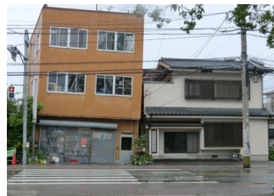
図 1.2.11 液状化による建築物の傾斜
