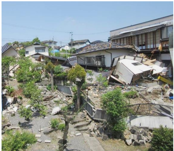
図 1.1.1 平成 28 年熊本地震の被害状況
