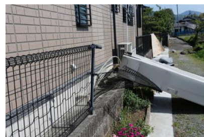
図 1.2.14 給湯施設の転倒 (熊本大学減災型社会システム実践研究教育センター)
