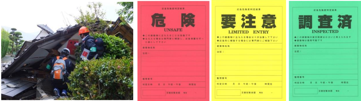
図 4.5.7 被災建築物応急危険度判定の様子、判定ステッカー
