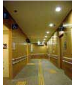
狭い廊下での車いすの通行にも配慮され た幅15cmの誘導ブロック(各階共通)
