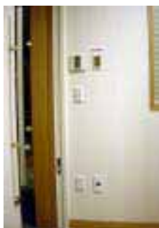
高さ95cmに設けられたワイドス イッチと40cmに設けられたコン セント(各室共通)
