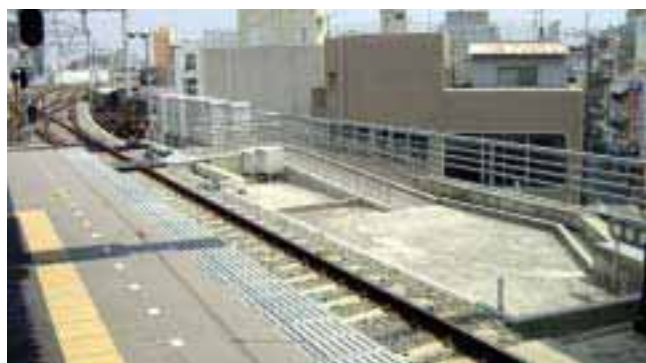
プラットフォーム横に設けられた一時待避所(阪急伊丹駅)
