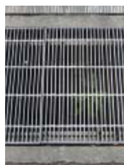
車いす等を考慮した溝蓋
