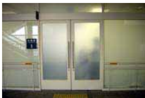
室内の状況がわかる半透明ガラスを採用した引き戸と衝突防止を兼ねた手摺の設置例(パレア)
