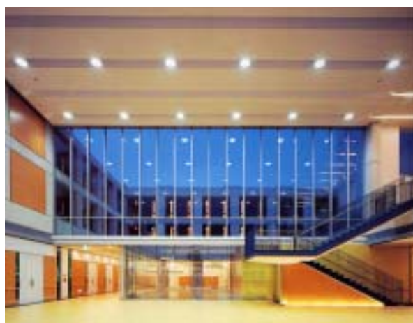
内部空間が一目でわかる建物構成 (国際障害者交流センター(ビッグアイ))
