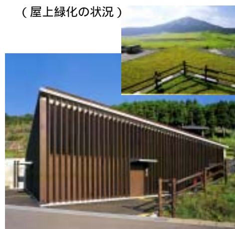
屋上緑化と木材の多用等により環境に 配慮したトイレ(草千里公衆トイレ) 写真家:宮井政次
