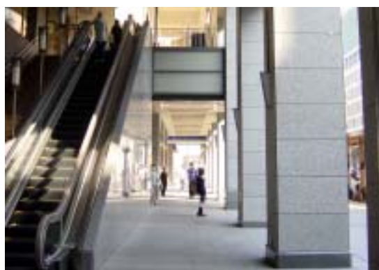
雨天時も快適に利用できる玄関前屋外通路 (びぶれす熊日会館内)
