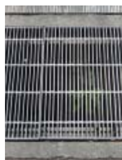
車いす等を考慮した溝蓋
