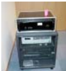
磁気誘導ループの設置
