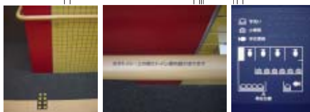
トイレ案内図（浮き出した絵柄と点字）を手すり点字と床面の点状ブロックで視覚障害者に知らせる仕組み（ビッグアイ）
