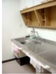
車いす使用者対応の流し台
