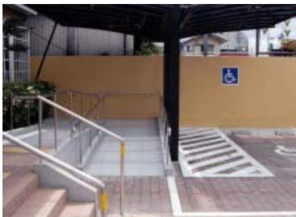
屋根の付いた車いす使用者用駐車場とスロープを設置した例
