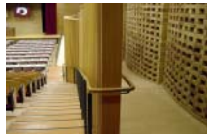
大会議室に設けられたスロープ
