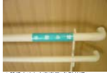
2段手すりりと点字表示(各階共通)
