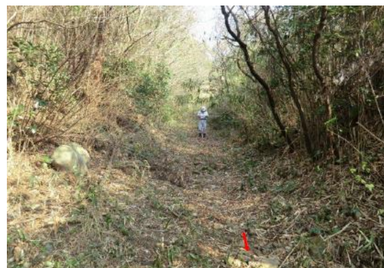
【溪流荒廃状況】
