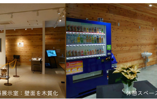
休憩スペース：一部壁面と天井を木質化
