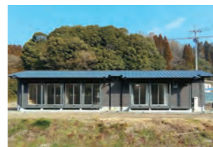
宮内防災センター [甲佐町]
