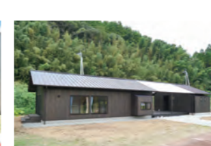
湖井公園 震災遺構ガイダンス施設 [益城町]
