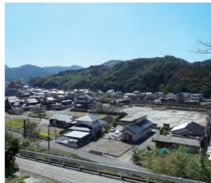
地域優良賃貸住宅の整備予定地と 芦北町湯浦地区のまち並み
