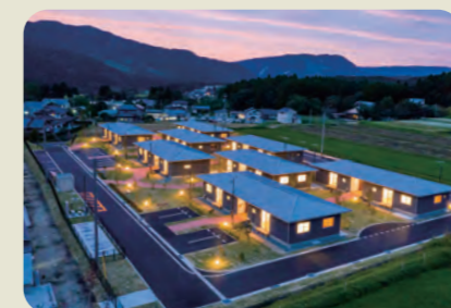
南阿蘇村買取型災害公営住宅 長陽西部・下西原第2団地
