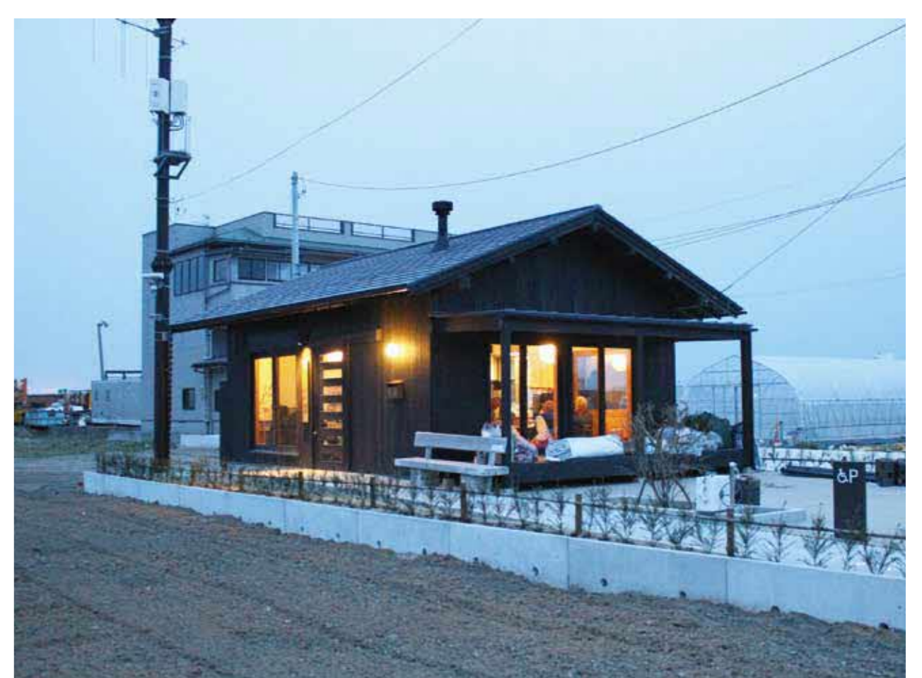
仮設団地の解体に伴い移築
