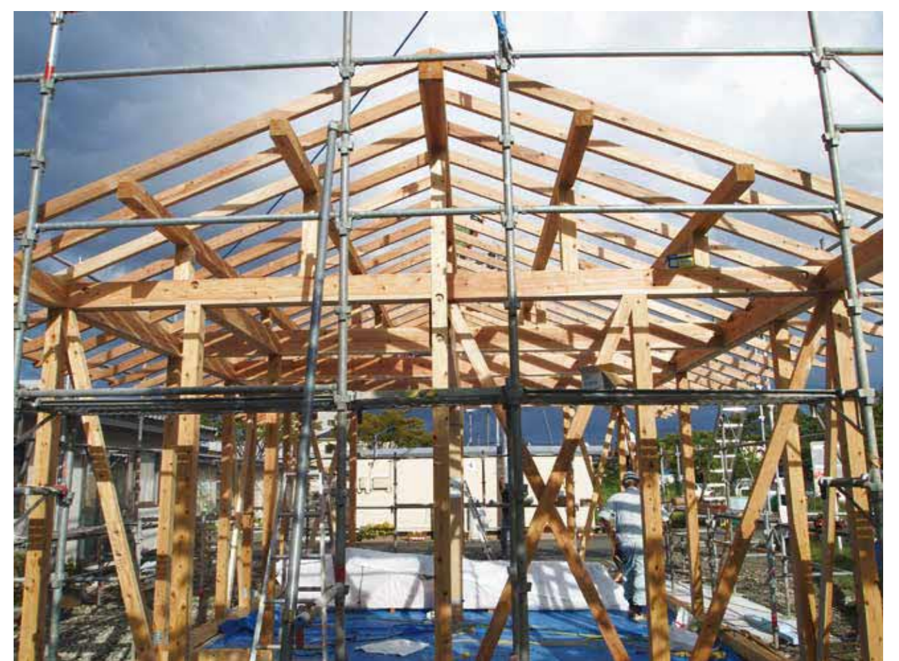
仮設住宅での建て方
