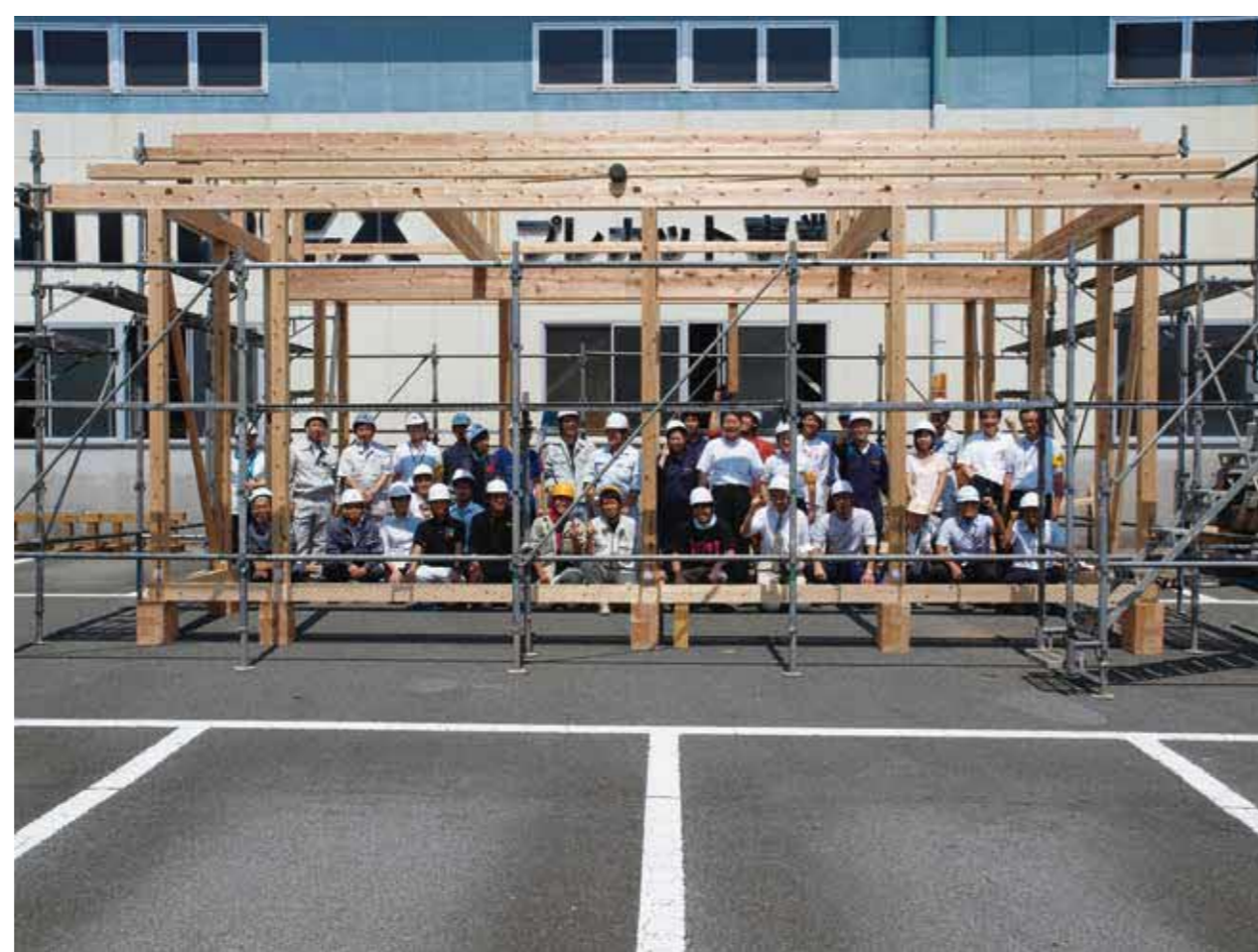
熊本での材料調達・仮組み
