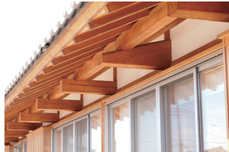
写真 3-1-19 出し梁及び出し桁
