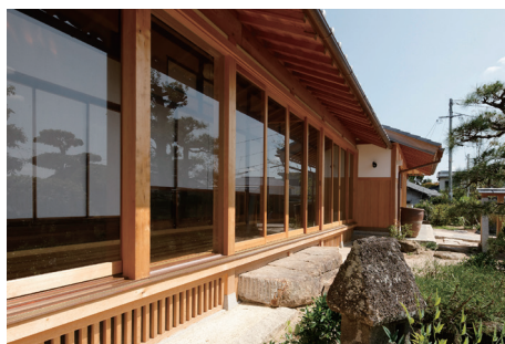
写真 3-1-22 現場製作による木製建具
