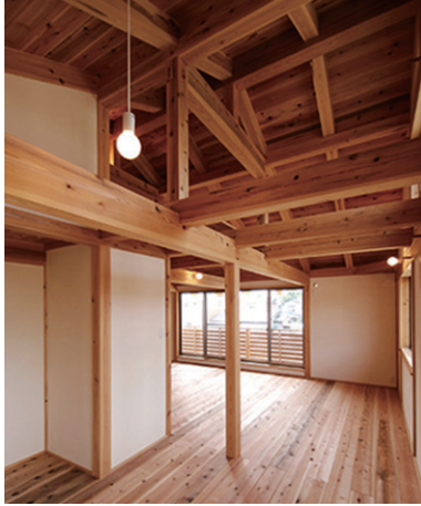
写真 3-1-3 小屋組・野地現し
