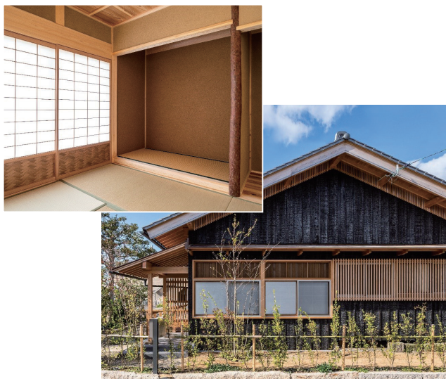
写真 2-3 片面真壁造の土塗壁
