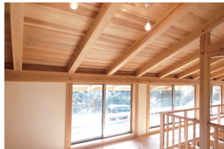
写真 3-1-20 化粧野地・面戸板現しにした例
