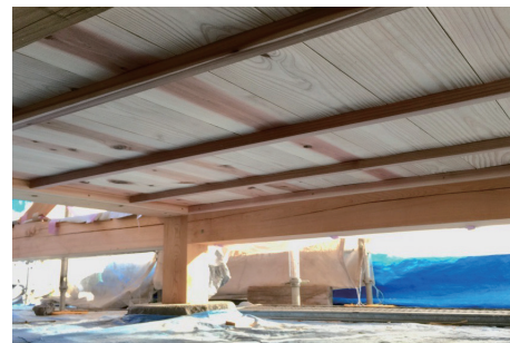
写真 3-1-17 断熱材が露出しないような対策を講じた開放的な床下
