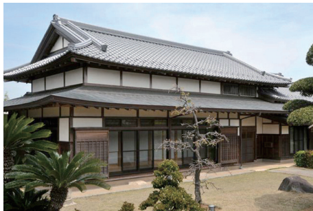
写真 3-1-5 土塗壁両面真壁（外部）
