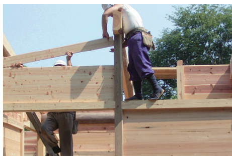
写真 3-1-10 落とし込み板壁（施工状況）
