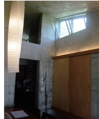
写真 3-2-13 通風のできる高窓 (ハイサイドウィンドウ)
