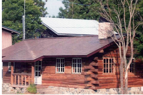
写真 3-1-14 丸太組構法 外部両面丸太現し（外部）
