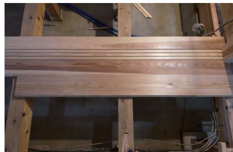
写真 3-1-31 厚板を用いた根太レス工法
