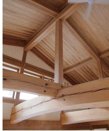
写真 3-1-4 小屋組・野地現し
