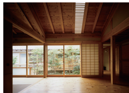
写真 3-1-23 現場製作による木製建具
