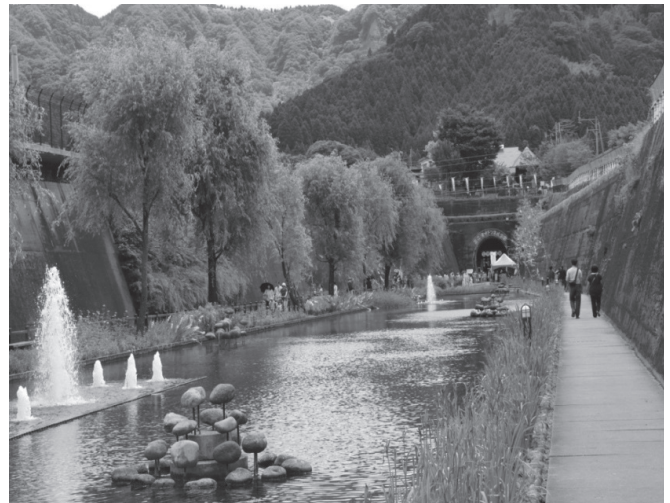
湧水トンネル
