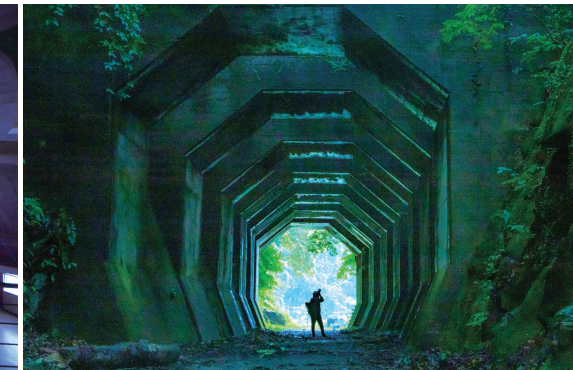
八角トンネル #taka.yoshi1212
