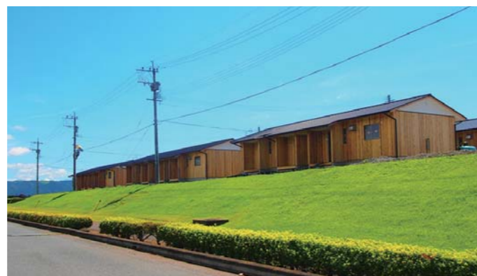
木造の応急仮設住宅(阿蘇市北塚仮設団地)
