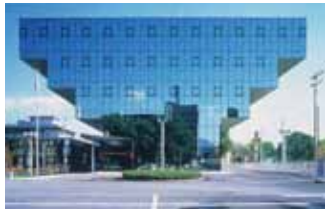
熊本北警察署(熊本市中央区) 設計/篠原一男+太宏設計事務所
