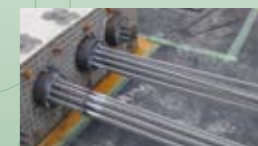
左から緊張後、緊張前、緊張後に切断処理した鋼線の様子
