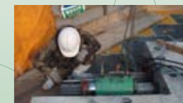
PC鋼線を緊張し、鋼線の伸びを確認
