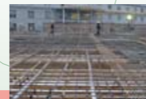
コンクリートスラブ配筋の様子
