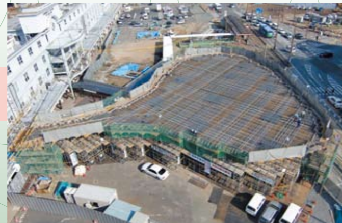
鉄筋、PC鋼線の組立 (2009年12月)
