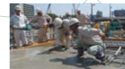
コンクリート打設後の固まり具合を確認
