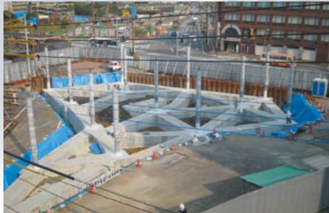
地中梁、鉄骨柱立込 (2009年10月)
