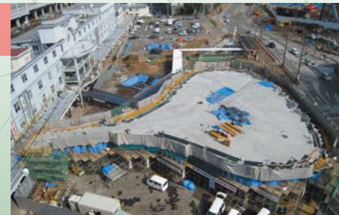
コンクリート打設、PC緊張 (2010年1月)
