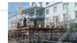
現場に設置したモックアップ
