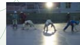
コンクリート表面仕上げは夜間に及んだ
