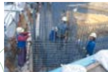
配筋作業を行う職人たち
