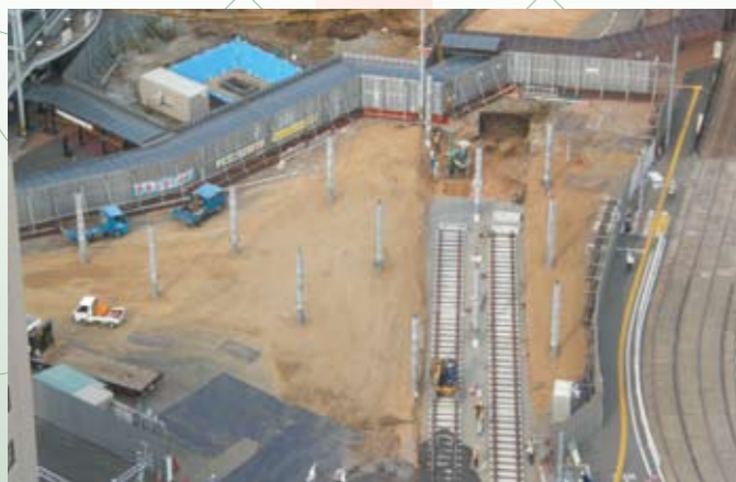
軌道の敷設 (2009年11月)
