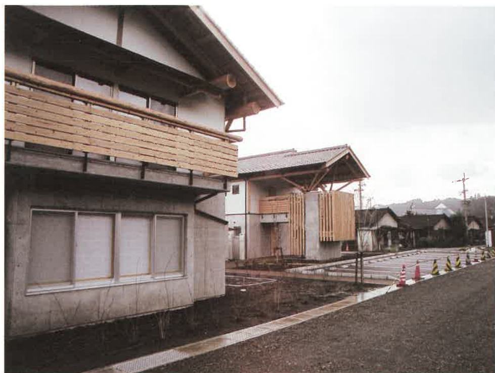
現在、2期工事が進行中。奥にはこれから建替えられる既存の町営住宅
