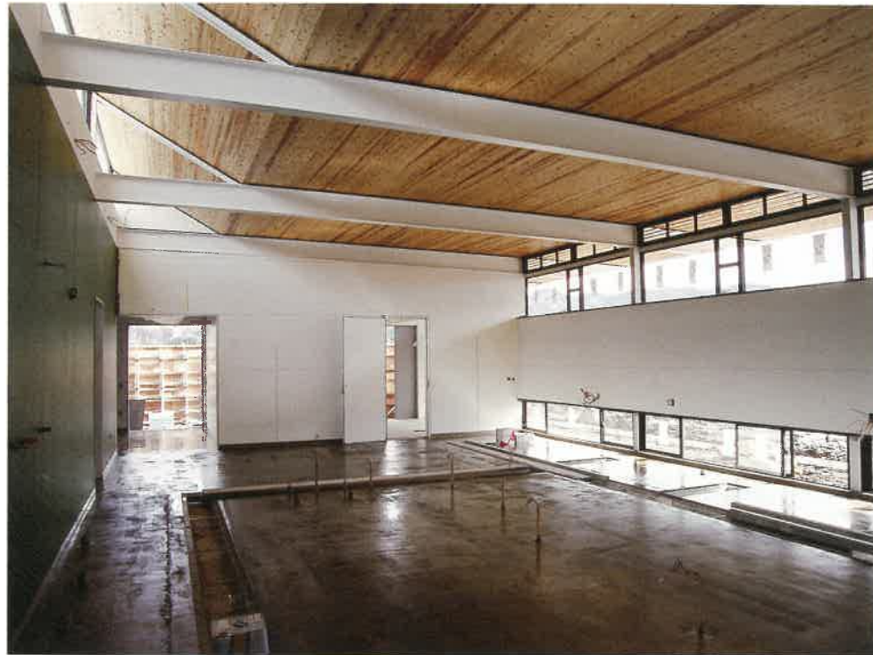
ハイサイドライトから光が射し込む作業室
