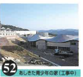
52 あしたの青少年の家(工事中) エリア・ゼンゲリス+エレニー・ジガンテス+鈴木二十島村建築設計事務所...青少年教育施設 芦北郡芦北町鶴木山地内...JR佐敷駅より車で20分
