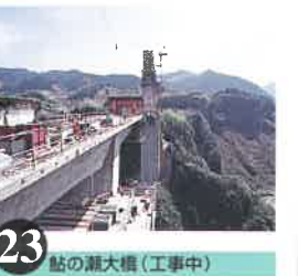
23 駅の瀬大橋(工事中) 大野美代子+中央技術コンサルタンツ...橋梁 上益城郡天部町
