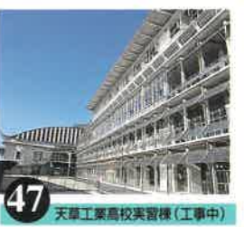
47 天草工業高校実習棟(工事中) 室伏次郎+SDA建築設計事務所...工業高校実習棟・体育館 本渡市島田町...本渡バスセンターからバス「工業高校前」下車
