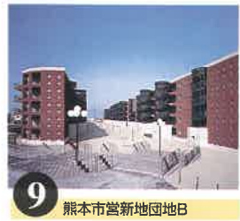
9 熊本市営新地団地B 緒方理一郎...共同住宅...92年3月 熊本市清水町新地1917...熊本交通センターから新地団地行きバス「新地団地」下車...外観のみ見学可、駐車不可
