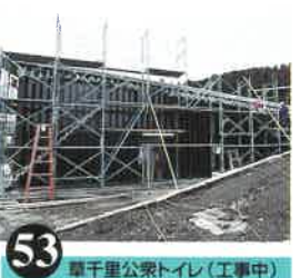
53 草千里公共トイレ(工事中) 塚本由晴+菅野建築設計事務所...公共トイレ 阿蘇郡阿蘇町
