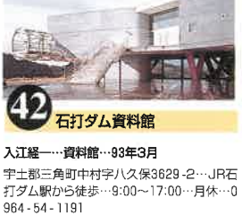
42 石打ダム資料館 入江隆一...資料館...93年3月 宇土郡三角町中村字八久保3629-2...JR石打ダム駅から徒歩...9:00~17:00...月休...0964-54-1191
