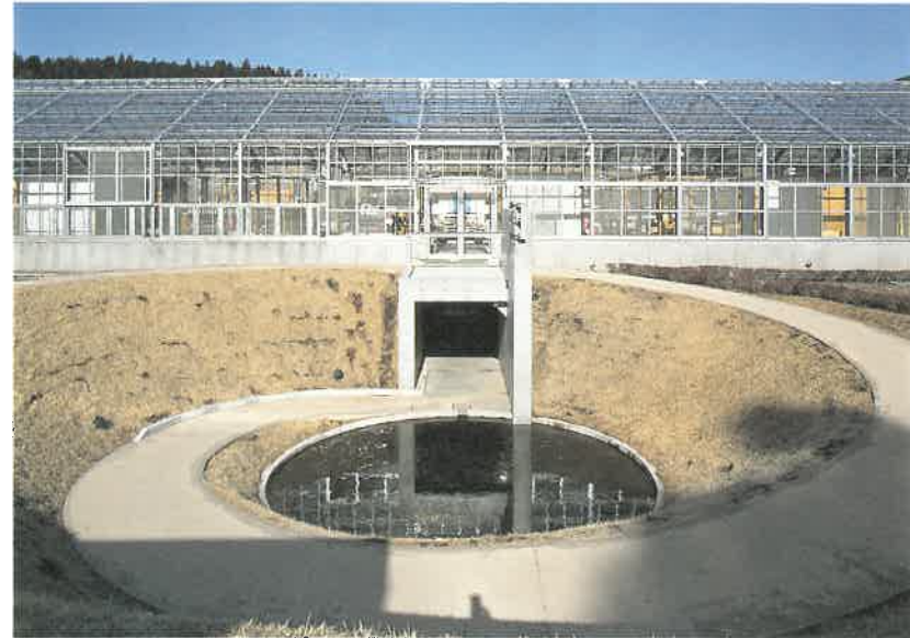
(上) アプローチ 撮影：石丸捷一
