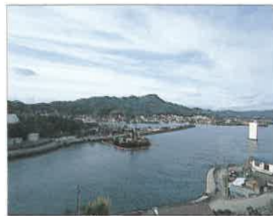
1997年の完成を目指す牛深港の海上にはコンクリートの巨大な橋脚が出現。海鳥が羽をやすめていた。
