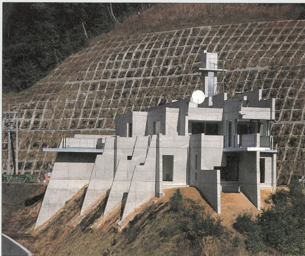
湖畔に建つ石打ダム管理所
