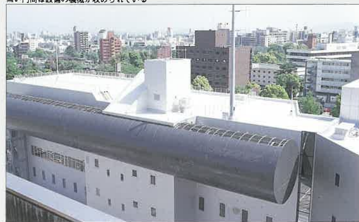
黒い円筒は設備の機械が収められている
