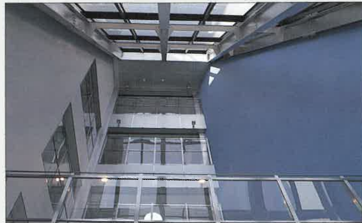
事務棟との間にあるガラス張りの吹き抜けを見上げる
