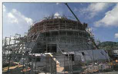
建設中の三角港フェリーターミナル
