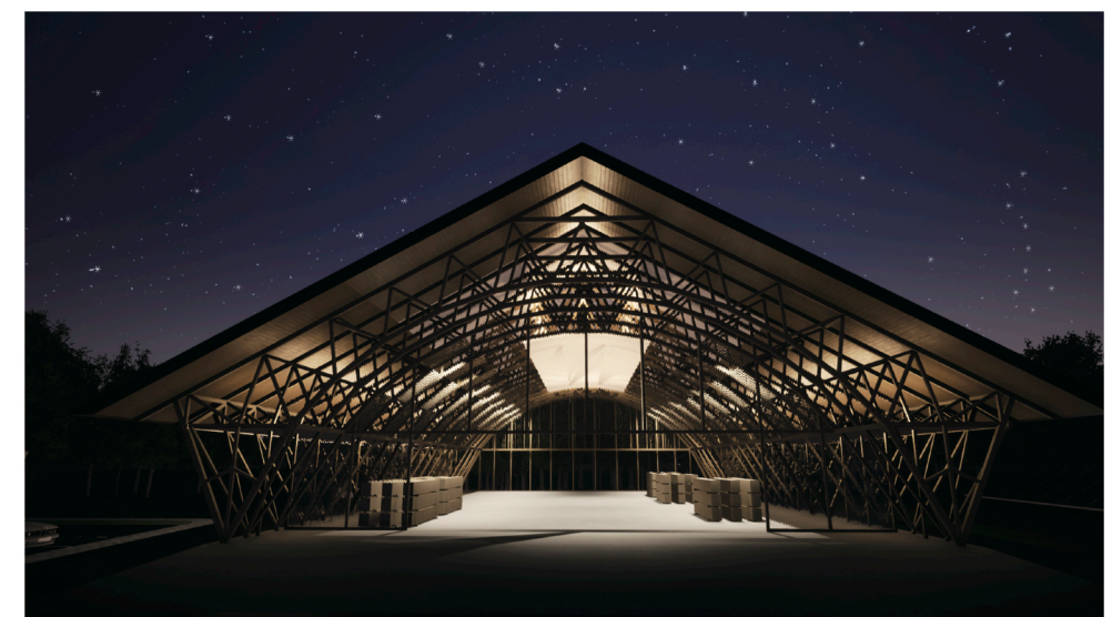
星空に浮かび上がるアーチトラスの架構
