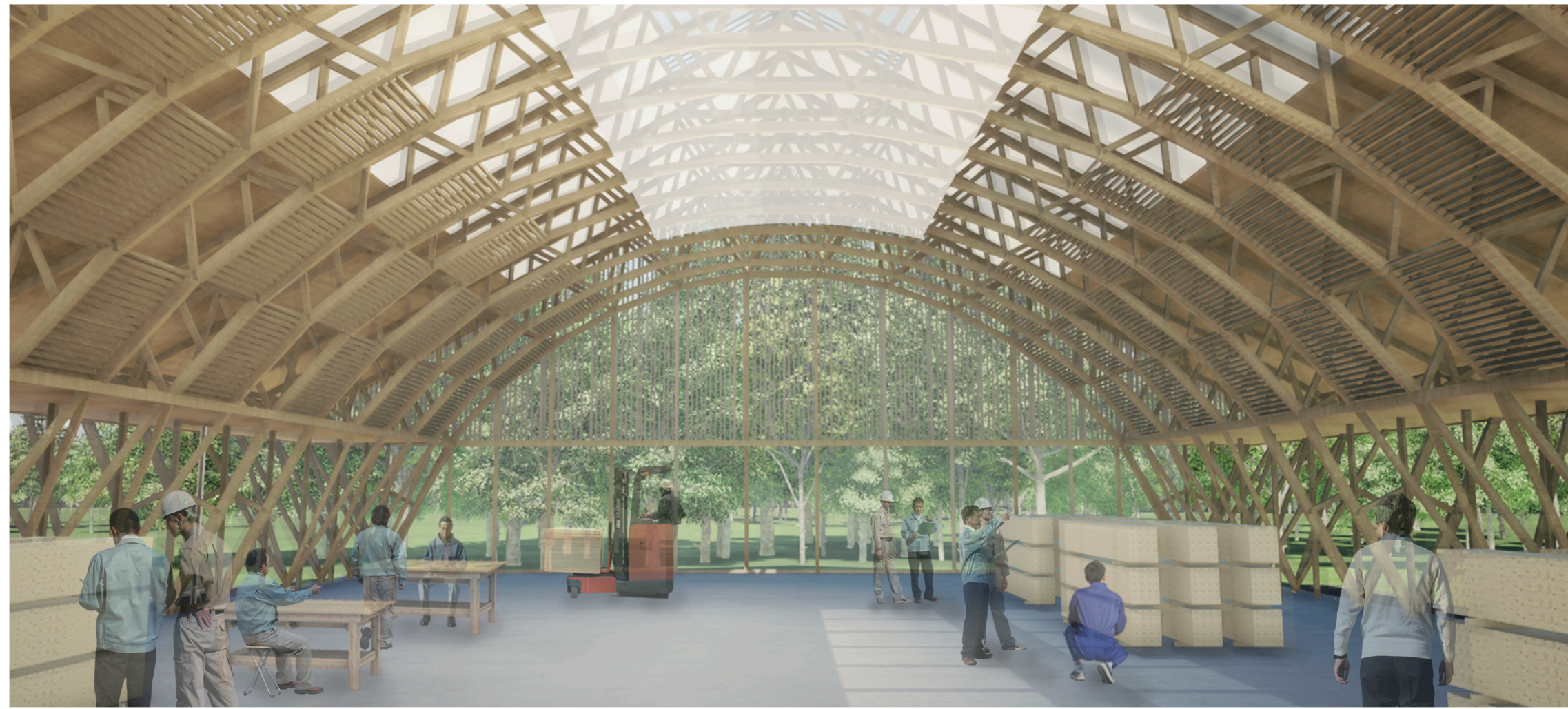
連続したアーチトラスの架構
