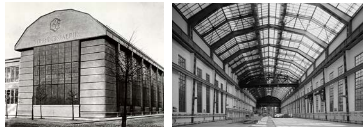
図1. AEGタービン工場 左: 外観 右: 内観
